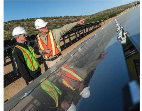
*Se instaló el campo de pruebas Caterpillar Tucson 500 kW de energía fotovoltaica respetuosa con el medio ambiente (PV) paneles solares para ayudar a complementar la energía generado a partir de grupos electrógenos en el sitio para reducir los costos de combustible y operación.*
