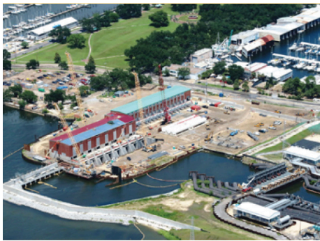
Estación de bombeo PCCP (Permanent Canal Closures and Pumps, Cierres permanentes de canales y bombas) de New Orleans
