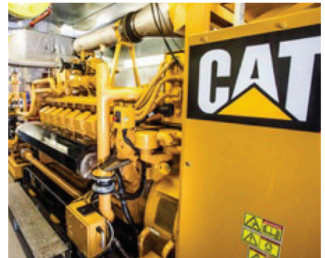
Sistema de cogeneración de gas Natural Cat G3516H
