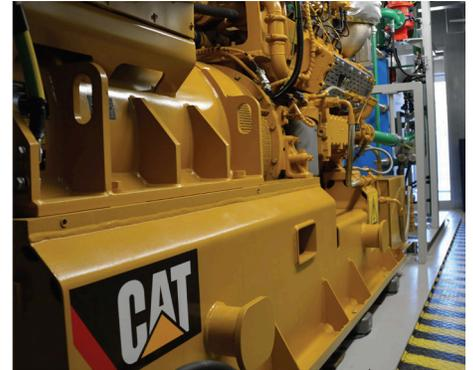
*Equipado con camisa de agua y escape. sistemas de recuperación de calor a gas, el Cat® CG132-08 El grupo electrógeno produce 1,4 MMBTU/h. (409 KWT) de energía térmica, que se utiliza para calentar el digestor.*
