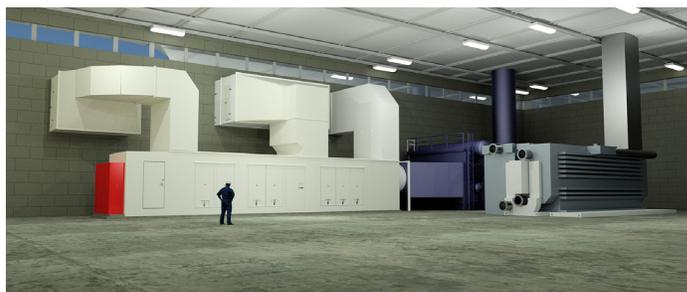
Установка тригенерации: PGM130 с парогенератором с регенерацией тепла (HRSG) и паровым абсорбционным холодильником вырабатывает 16,5 МВт электроэнергии и примерно 28 МВт охлажденной воды (прим. 8000 тонн охлаждения)
