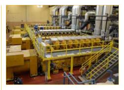
Cuatro grupos electrógenos de gas Cat® G16CM34 producen 25 MW de potencia para complementar la energía generada a partir de fuentes eólicas.
