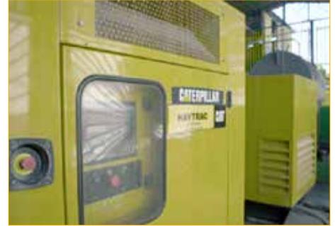
*Un nuevo grupo electrógeno diésel Cat® 3512 proporciona más de 1 MW de potencia para apoyar la misión de la fundación.*
