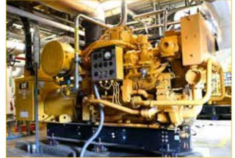
*Después de la instalación de un segundo Grupo Electrónico Cat G3508 de gas en el 2015, la WWTP generó más energía eléctrica en el lugar de la que consumió a partir de la cogeneración de biogás renovable y energía solar.*
