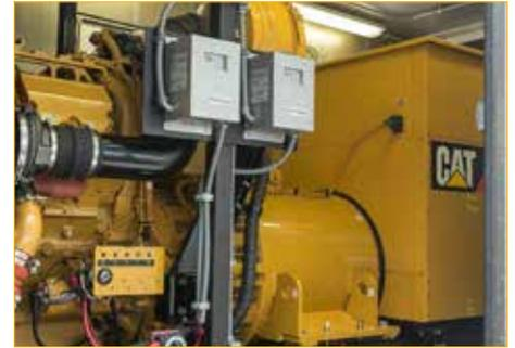
*El Complejo de Seguridad Pública requiere un sistema de energía de respaldo de emergencia para soportar funciones críticas en todo momento. Ring Power desarrolló un diseño de sistema N+1 que incluye tres grupos electrógenos diésel Cat® C32 y aparamenta en paralelo.*
