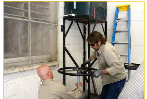
La planta Manti Upper, que funciona las 24 horas del día y los 365 días del año, sirve como recurso de carga base de energía a la UMPA, al tiempo que suministra una parte de las necesidades de energía de Manti.
