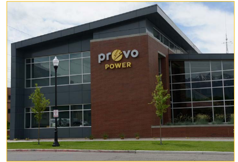
La nueva central eléctrica y los grupos electrógenos proporcionan un aire más limpio a Provo, Utah.
