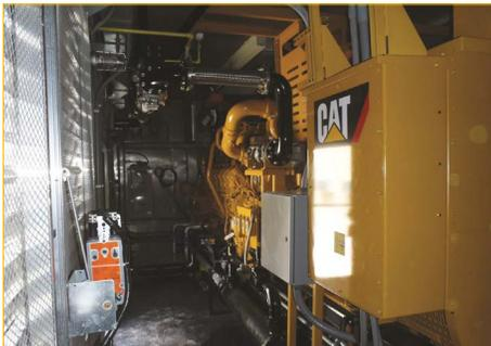
*Todo el paquete se diseñó teniendo en cuenta la capacidad de servicio, con suficiente espacio libre lateral y superior para el motor, y secciones extraíbles para reconstrucciones importantes.*
