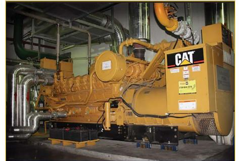
*Los nuevos grupos electrógenos utilizarían el biogás recuperado de la planta para generar energía y transferirían el calor residual a una fuente de enfriamiento.*
