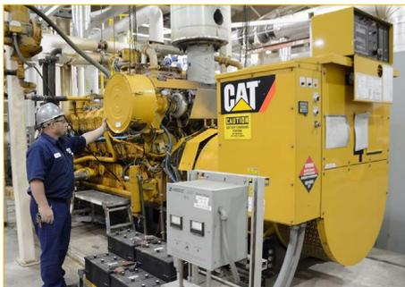
*Tres Grupos Electrónicos G3516B Cat® producen 2,4 MW de potencia. Un cuarto brinda potencia de reserva para el mantenimiento programado.*
