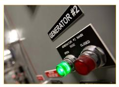
Los Grupos Electrógenos 3516 cuentan con un controlador que proporciona un grupo electrógeno múltiple con capacidad de puesta en paralelo.
