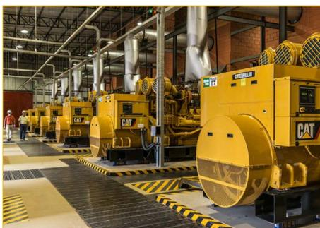
*El Grupo Electrónico Cat® C175-20, que suministra 3.150 kW de potencia bruta en aplicaciones de potencia continua, requiere menos mantenimiento y proporciona la máxima densidad de potencia de cualquier grupo electrógeno diésel de alta velocidad disponible en el mercado en la actualidad.*
