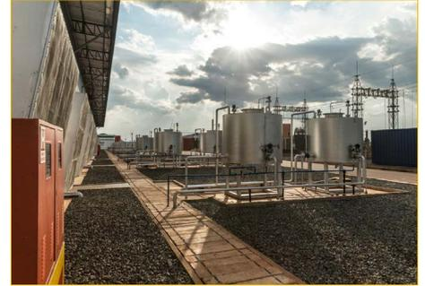
*Para garantizar que los motores se desempeñen a sus niveles óptimos, el combustible diesel se el sitio, se pasa por tubos a través de un sistema de filtrado y centrifugado de múltiples etapas, se bombea a los tanques principales y, finalmente, se traslada a tanques de 4.000 litros que alimentan cada grupo electrógeno.*
