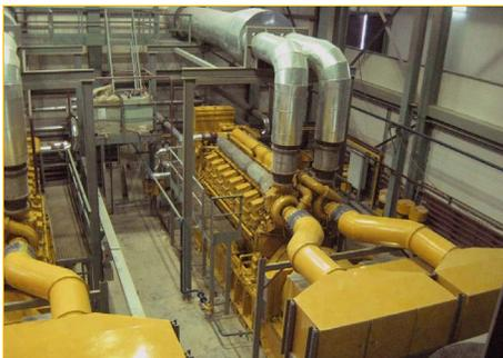
*Los grupos electrógenos Cat usados estaban específicamente diseñados para operar con aceite crudo y también proporcionar a Polyus una salida alta y fiabilidad a costos de operación bajos.*
