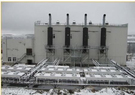
*La planta de CHP de 17,2 MW, alimentada por cuatro grupos electrógenos Cat® 3616 nominales a 4,3 MW, es la primera planta de energía en Rusia que funciona con aceite crudo.*
