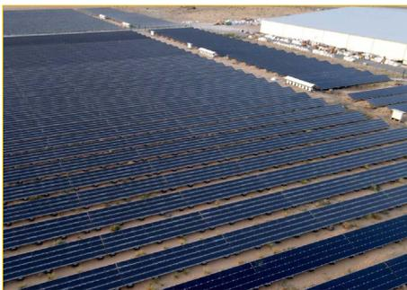
*El sistema cuenta con casi 23.000 módulos fotovoltaicos PVT117 Cat® que generan hasta 2,7 MW de energía solar para la planta durante las horas del día.*
