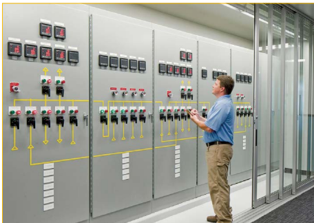
Scott Data Center en Omaha, Nebraska.
