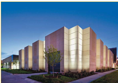
Scott Data Center es uno de los cinco centros de datos para múltiples usuarios de la nación en obtener una certificación nivel 3.
