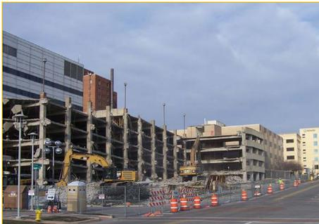
*Durante la demolición de un estacionamiento de cinco pisos como parte de un proyecto de expansión, colapsó parte de la plataforma. Esto hizo que se incendiara un transformador y se pusiera en peligro la energía del atrio adyacente.*
