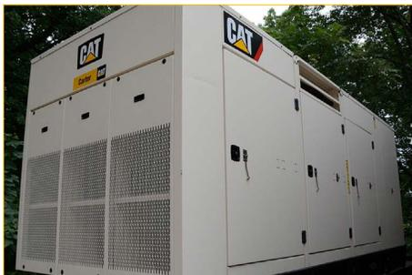
Monticello utiliza un grupo electrógeno diésel Cat® C15 ACERT de 500 kW equipado con un recinto insonorizado y protegido de la intemperie para minimizar el ruido.
