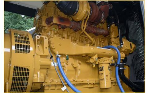
*En Montalto, se instaló en 2010 un grupo electrógeno diésel Cat® C15 de 350 kW y el correspondiente interruptor de transferencia automática (ATS), que suministra potencia de respaldo al Centro Robert H. Smith.*
