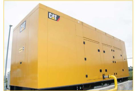
*Las celdas solares proporcionan en esencia toda la energía a la microrred, mientras que un Grupo Electrónico G3412 Cat® garantiza la potencia continua cuando se esconde el sol.*
