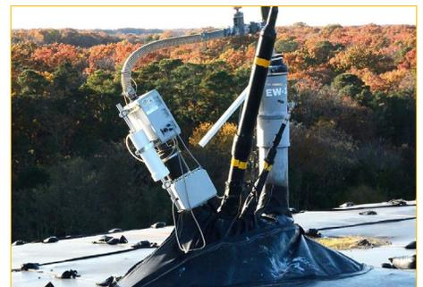
*El distribuidor Cat diseñó y construyó el sistema de conductos de gas caliente, la nueva estructura de tubo de escape vertical y la plataforma de contención. También instaló el sistema Heartland Concentrator.*
