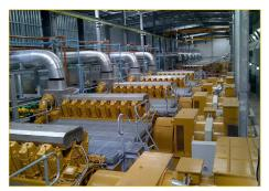
El distribuidor Cat<sup>®</sup> y Caterpillar entregaron 13 grupos electrógenos a gas CG260 Cat y componentes de instalación adicionales.
