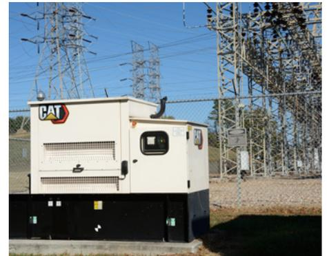
*Los generadores diésel de Cat®, alojados en casetas exteriores, se han instalado en las subestaciones de Lenoir City Utilities para suministrar energía en caso de apagón. Equipado con Cat Connect, el personal puede supervisar de forma remota el estado de 15 grupos electrógenos de reserva de Cat en lugares sin personal.*
