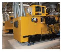
El Hospital Infantil de Nueva Orleans cuenta con cuatro grupos electrógenos diésel Cat C32 y dos grupos electrógenos diésel 3508 para garantizar una energía de emergencia fiable en caso de una catástrofe natural en el área propensa a los huracanes.
