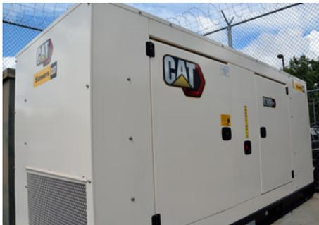
*El grupo electrógeno GC D300 de Cat® encaja en el espacio del grupo electrógeno anterior y utiliza los depósitos de combustible diésel que ya había instalados en la prisión.*
