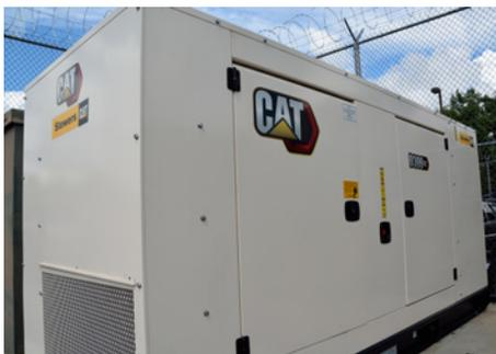
*O grupo gerador a diesel Cat® D300 GC se encaixa no lugar ocupado pelo grupo gerador anterior e utiliza os tanques de combustível diesel já instalados na prisão.*
