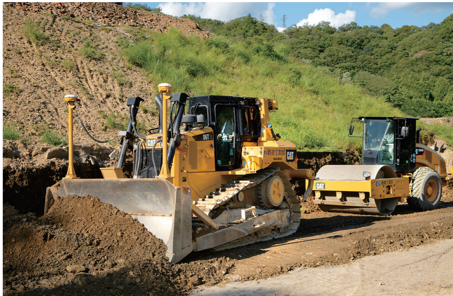
息の合ったコンビネーションで敷き均しと転圧を行うD6T XLとCS54B。
