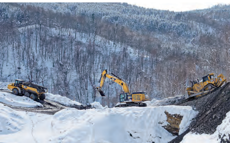
傾斜地作業でも優れた車両安定性を発揮するCatマシン(左から順に740GC、349EL、D8T)。
