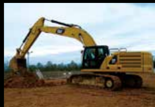
確かな品質を約束するための連続掘削試験
