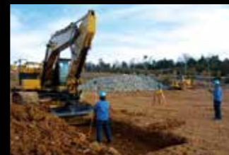
半自動制御での高い土木施工精度の追求
