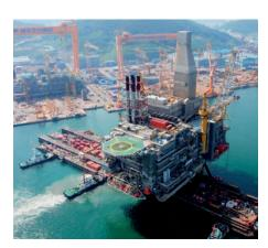
海上平台/FPS0 提取、加工和储存石油和天然气,直至 可运至岸上进行精炼和提取。
