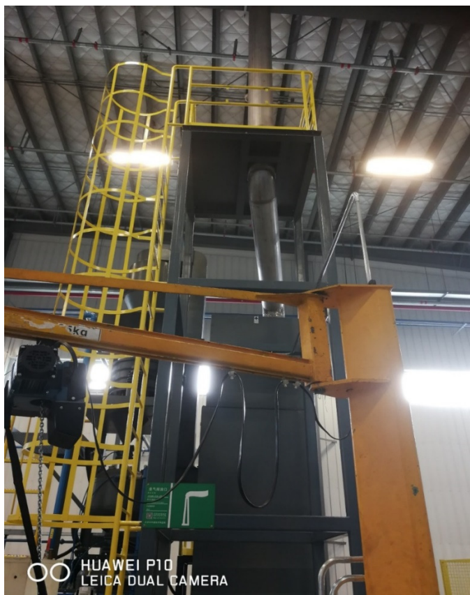
图4-1 20m高排气筒及采样平台
