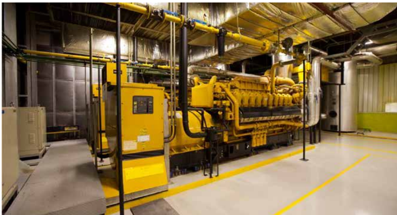
Imagem 1: Quatro grupos geradores G3520C ajudam a alimentar e resfriar uma das maiores fábricas comerciais de São Paulo
