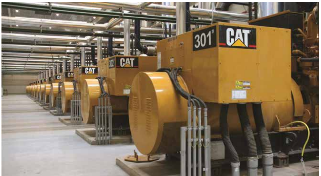
Imagem 2: O interior de uma das quatro usinas de energia de gás de carvão que utilizam geradores a vapor de recuperação de calor de escape para alimentar uma turbina a vapor de 3 MW
