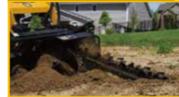
トレンチャ(溝を掘る)
