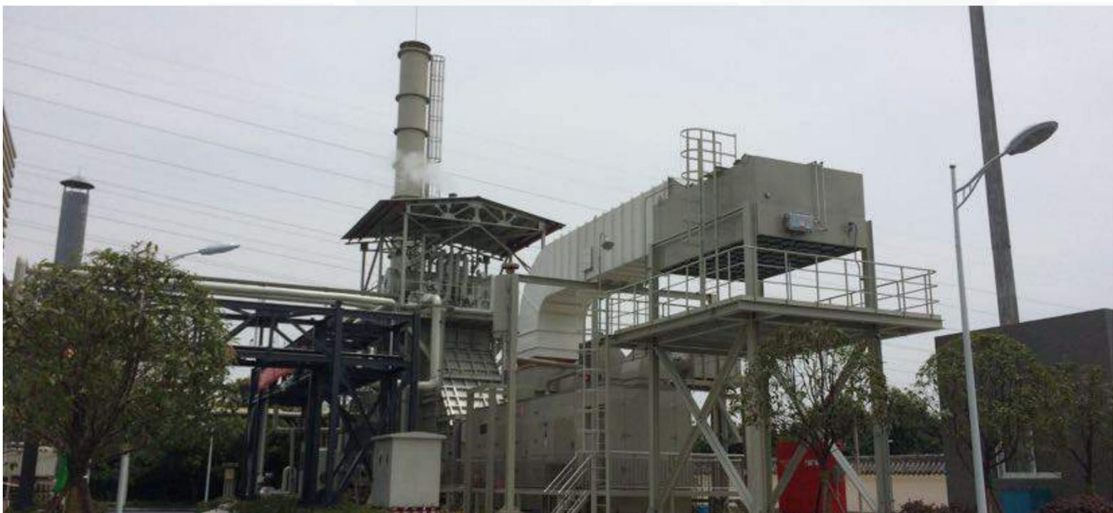
卡特彼勒的子公司索拉透平公司是全球领先的分布式能源和热电联产设备制造商。四川能投天然气分布式能源公司是索拉透平在中国的一个重要客户。该公司的“新都华润雪花啤酒分布式能源项目”通过冷热电三联供技术为华润雪花啤酒厂提供生产所需的蒸汽、电力以及工艺冷水。
