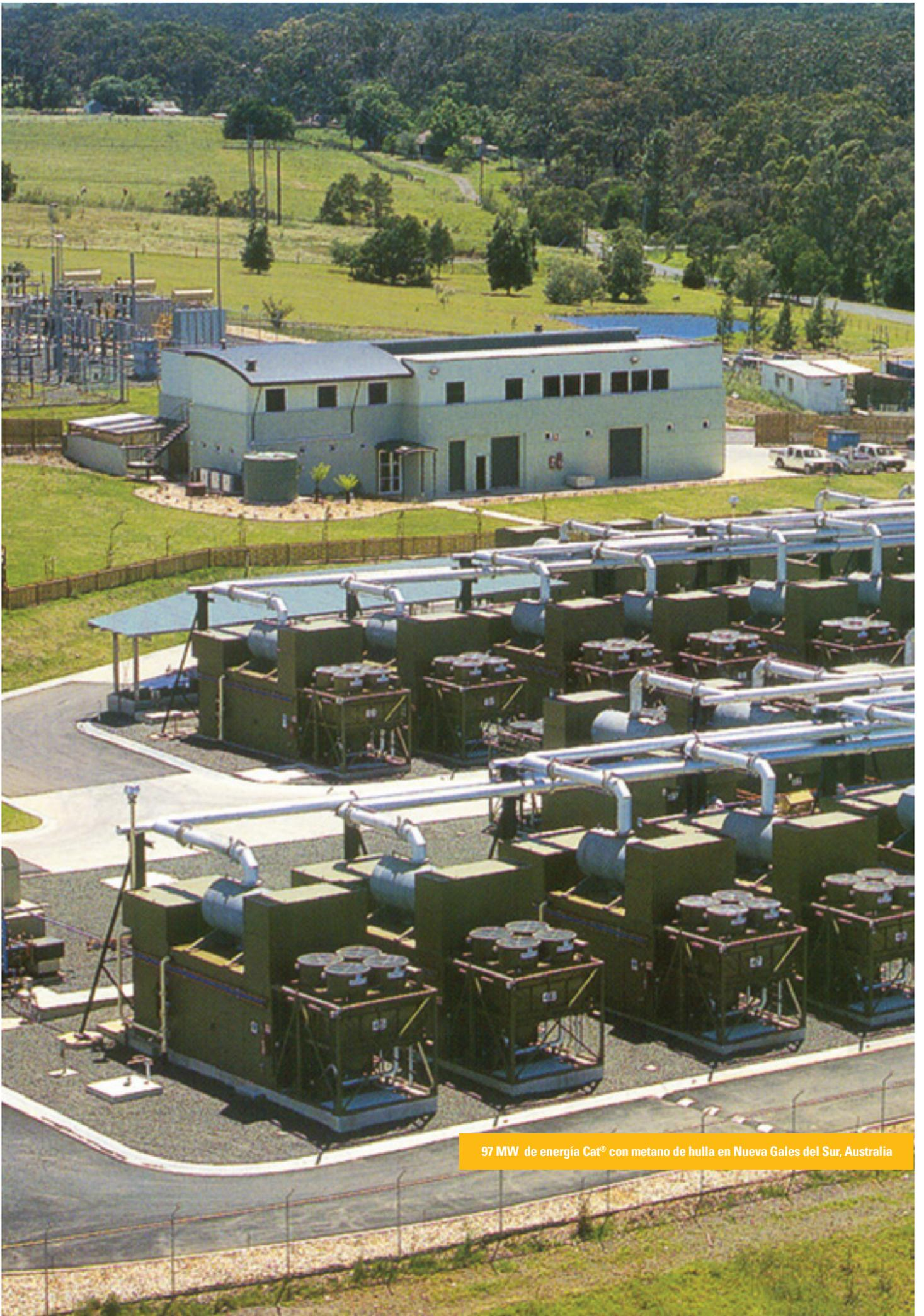
97 MW de energía Cat® con metano de hulla en Nueva Gales del Sur, Australia
