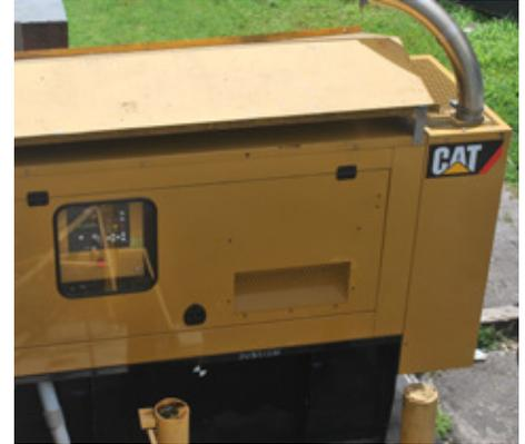
*Una planta eléctrica diesel Olympian™ D100-6S de 100 kW, que proporciona respaldo para toda la panadería, incluidos el aire acondicionado, la iluminación, los refrigeradores, los hornos y las cajas registradoras.*
