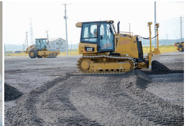
(株)ヒルタ様のモータブルの施工現場。D3Kが敷き均した土砂をCS54Bで締め固めていきます。
