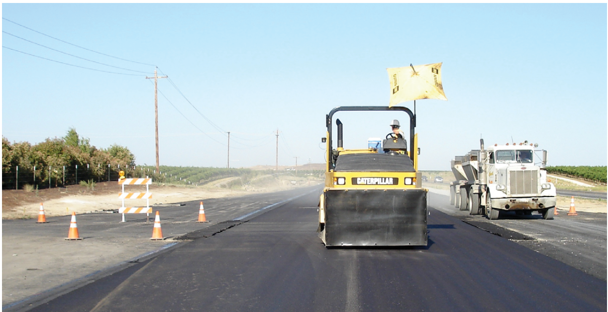
El compactador neumático sella la junta longitudinal caliente / fría.
