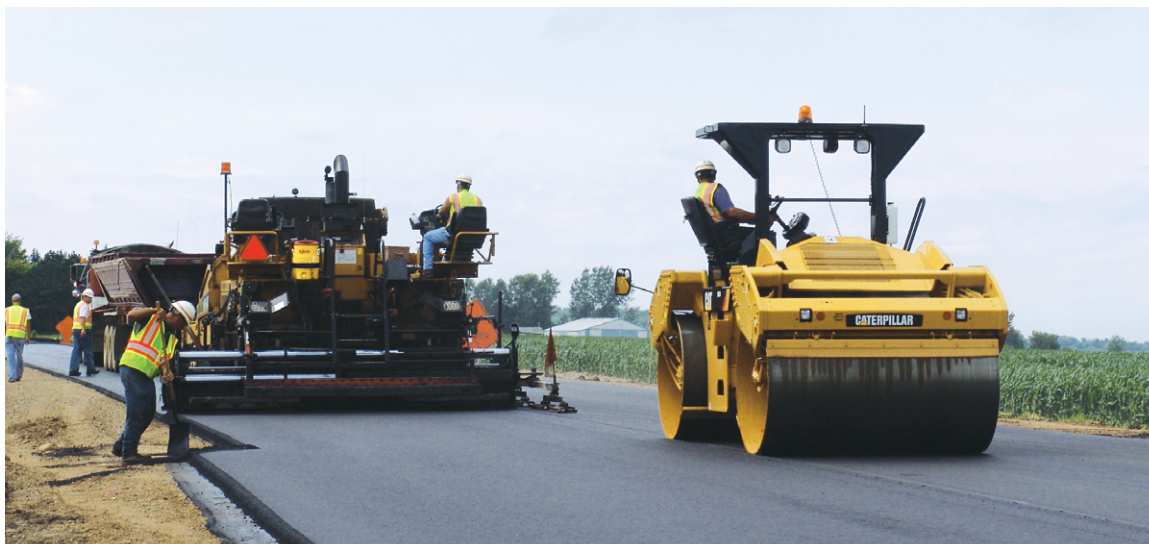
Sellar la junta longitudinal durante la primera pasada mejora la apariencia de la junta.
