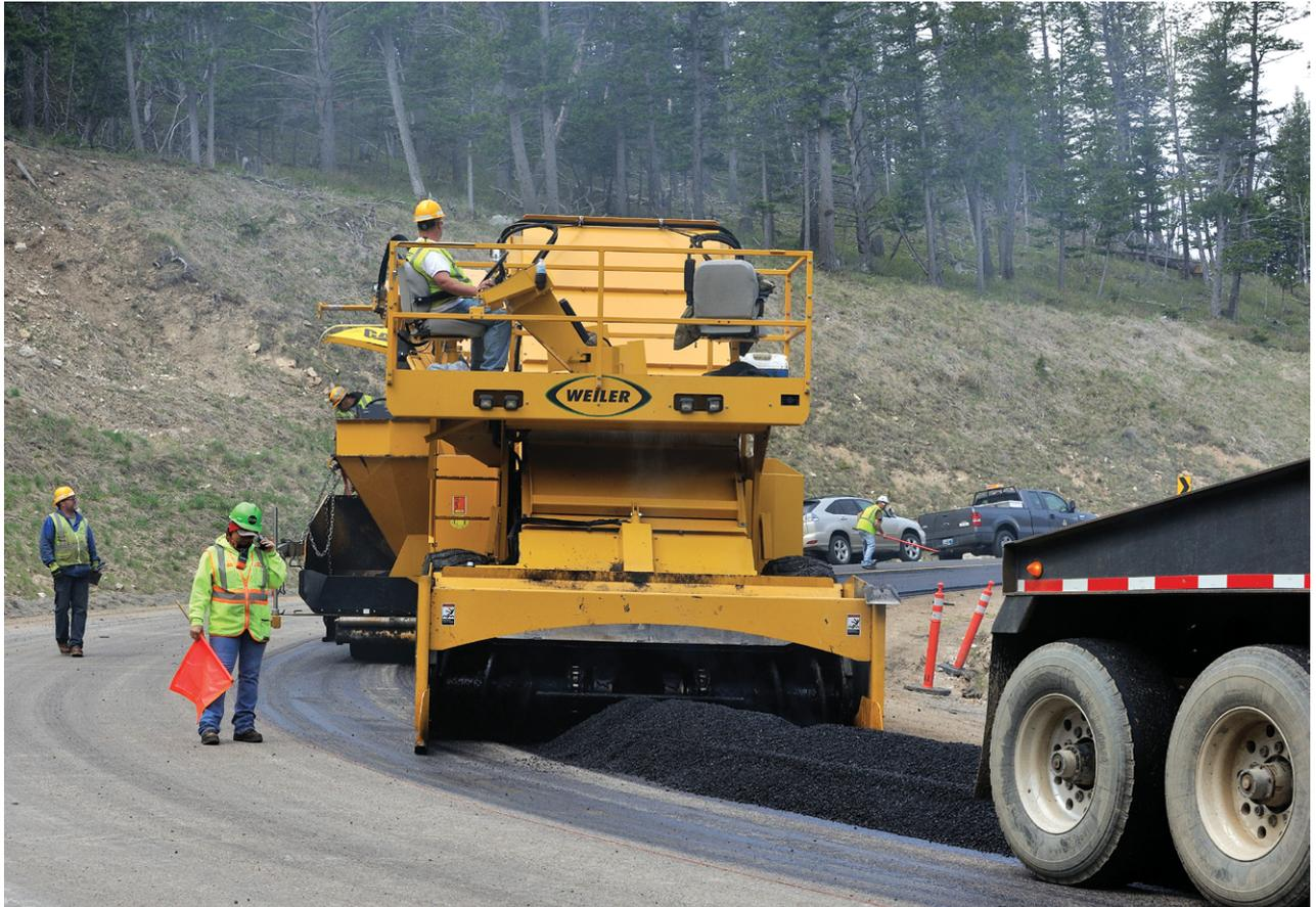
Los dispositivos de transferencia de material (este está equipado con una carga de elevación de hilera) permiten que la pavimentadora opere de manera continua a la misma velocidad.
