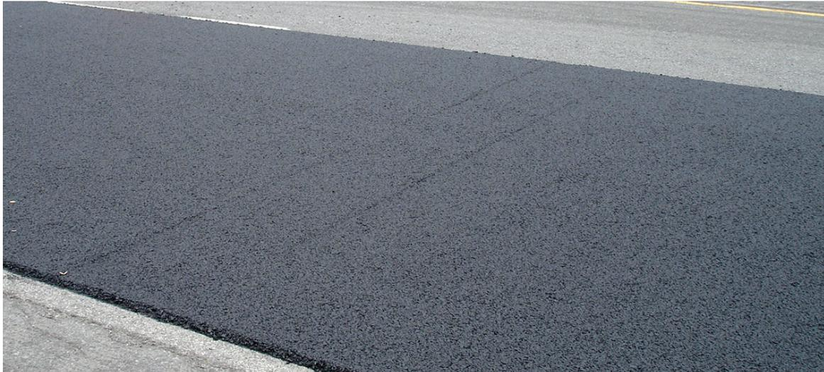
Huella del reglón en la capa bituminosa ocasionada por detener la pavimentadora.
