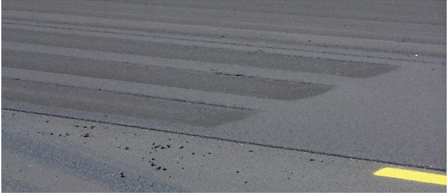
Los compactadores neumáticos tienen permitido detenerse en forma recta en la carpeta asfáltica.
