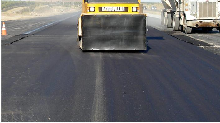
*El uso de compactadores neumáticos en la fase intermedia es más eficaz para sellar juntas caliente/frío longitudinales.*
