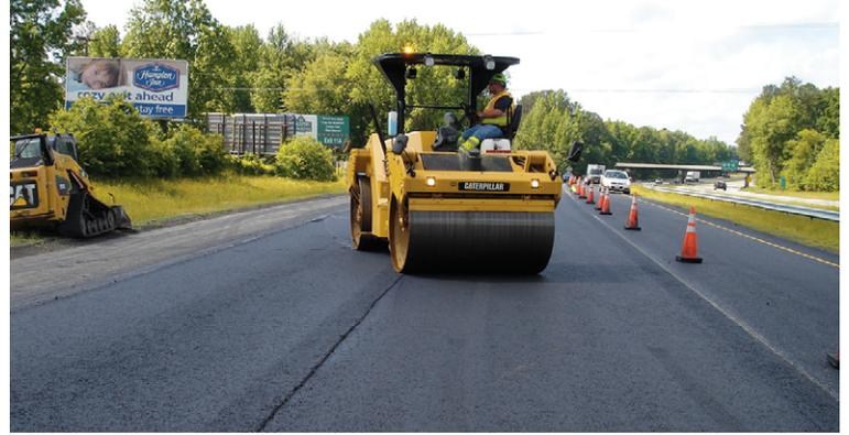
*Cuando el compactador puede rodar hasta una carpeta asfáltica compactada y fría se evita dejar marcas de la parada de los tambores en la carpeta asfáltica fresca.*
