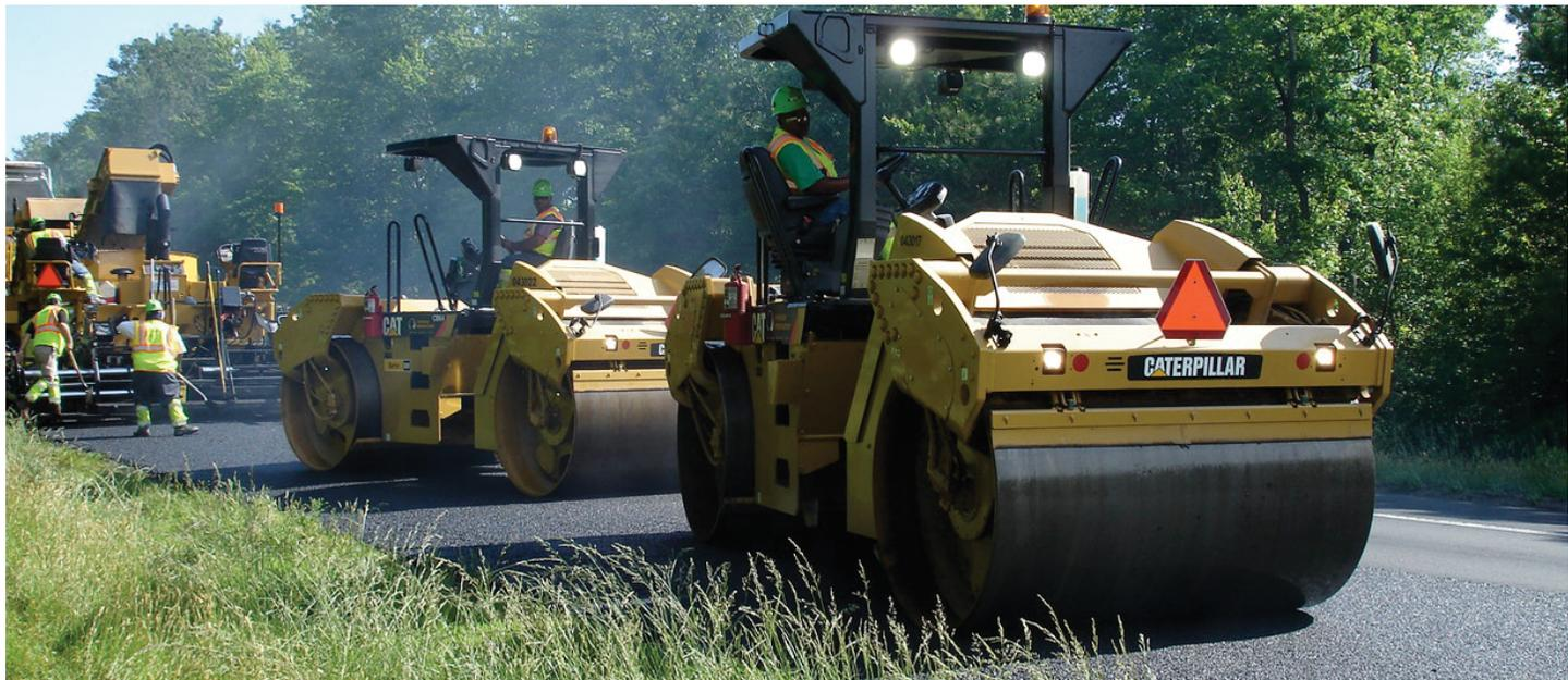
Dos compactadores de fase inicial dando reversa detrás de la pavimentadora. Realizan una parada en ángulo.
