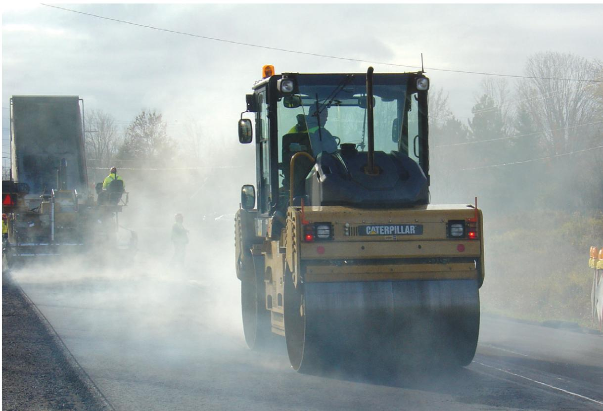
Una operación consistente de la máquina pavimentadora y el compactador de la fase inicial son clave para lograr una densidad consistente.
