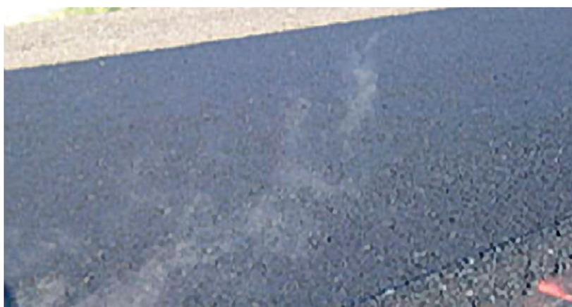
Variación en la temperatura causada por una parada de más de 10 minutos de la máquina pavimentadora. La impresión de la plancha que se ve en la imagen infrarroja no es visible en la imagen digital.
