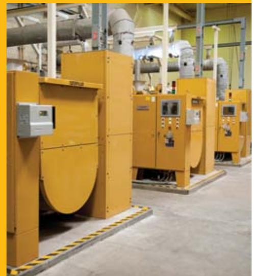
*El biogás producido por el proceso de tratamiento del agua en la Instalación de Control de la Contaminación del Agua de Encina alimenta cuatro Grupos Electrógenos con Motor Cat® G3516 para obtener energía renovable.*
