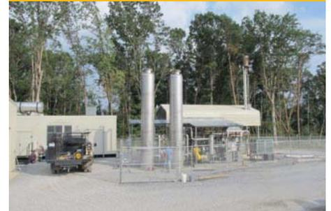
*La planta de transformación del gas a energía en rellenos sanitarios en el relleno sanitario Alcoa convierte el 95 por ciento del gas metano recuperado en energía, lo que genera electricidad suficiente para suministrar energía eléctrica a aproximadamente 750 hogares.*
