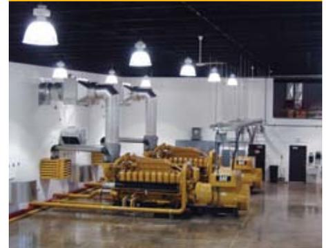
Fase 1 de la construcción de la planta de energía. Dos Grupos Electrógenos G3520C de alto voltaje a 2.050 ekW.
