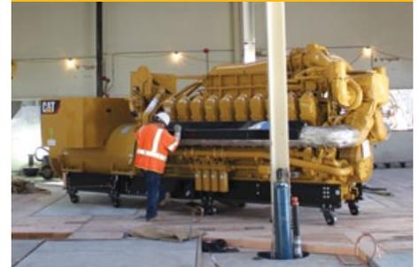
Помимо обеспечения резервного питания, дизельный генератор может запустить всю установку с обесточенной шины, без освещения, из полностью обесточенного состояния.
