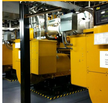
*Питание современной установки для комбинированного производства тепла и электроэнергии мощностью 6,2 МВт, работающей в One Penn Plaza, осуществляется за счет трех газопоршневых двигателей Cat® 2055 кВтэ и трех парогенераторов с регенерацией тепла (HRSG) Cat G3520C, которые установлены на территории здания в кожухе, обеспечивающем пониженный уровень шума.*
