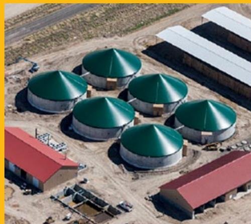
*Чтобы устранить неприятный запах, возникающий при переработке коровьего навоза, компания Bettencourt Dairies установила на ферме Rock Creek Dairy шесть установок для анаэробного брожения производительностью по миллиону галлонов каждая.*
