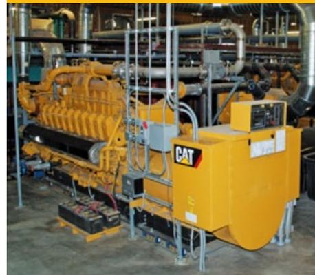
*Метан поступает в две газовые генераторные установки Cat® 3520C, которые преобразуют газ в электричество. Электроэнергия, произведенная генераторами, продается местной электросети штата Айдахо для распределения в главной электросети.*
