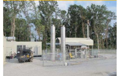
Электростанция по получению энергии из газа, образующегося из органических отходов, на полигоне Alcoa Landfill перерабатывает около 95 процентов выделяемого метана в электроэнергию, производя один мегаватт электричества. Такого количества достаточно для освещения примерно 750 домов.
