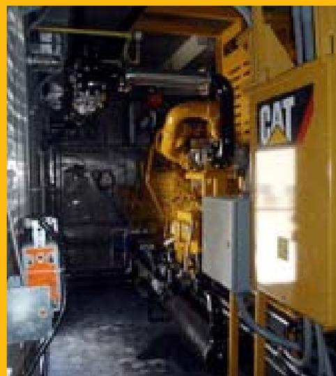
С момента установки в августе 2011 года генератор Cat® G3516 проработал 3000 часов при средних показателях мощности в 98-99% и простаивал только при отключении главной электросети или при проведении незначительного технического обслуживания.
